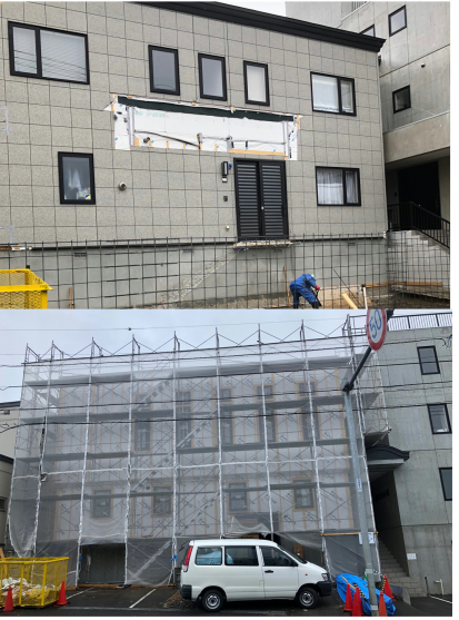
(上)五月中旬 (下)七月中旬 工事進行状況
