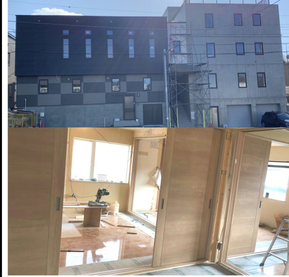
(上) 建物外観 (下) 新本堂内装工事
